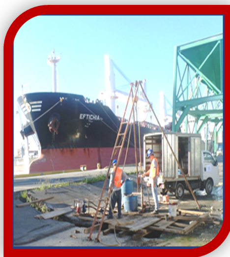
Foto 3 – Execução do ensaio SPT manual.
